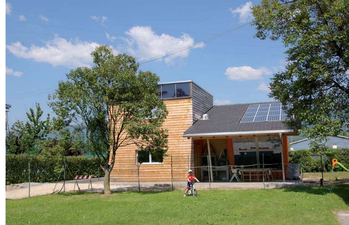
Vista del fronte sud con l'impianto fotovoltaico integrato in copertura
